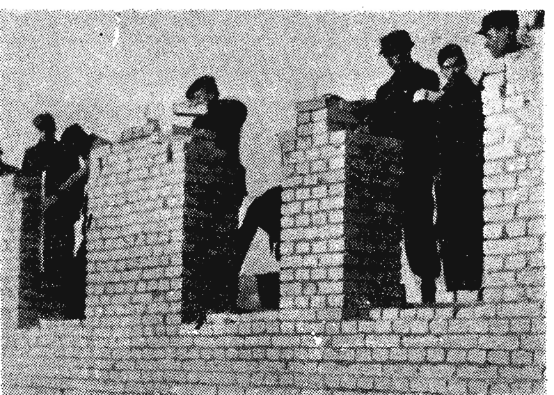
Rosną mury nowych domów i zabudowań w spółdzielniach produkcyj-nych.
