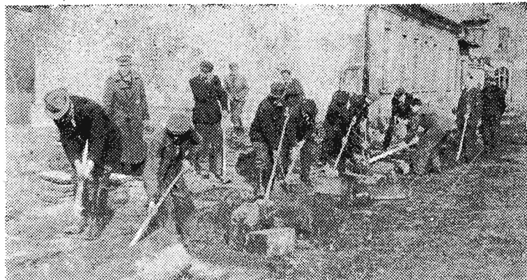
Założenie jezdni, chodników i krawężników na przestrzeni 120 m wykonane będzie w ramach czynu 1-Majowego przez pracowników samorządowych miasta Rzeszowa. Do podobnego czynu wezwali oni samorządowców z Przemysła.
