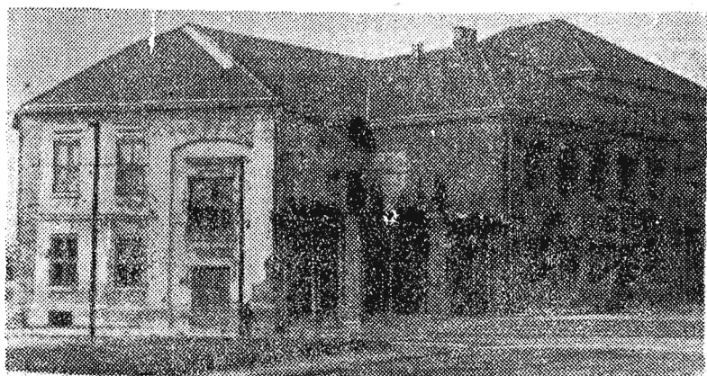
Dom Kultury w Jaśle przed ostatnim wykończeniem.
