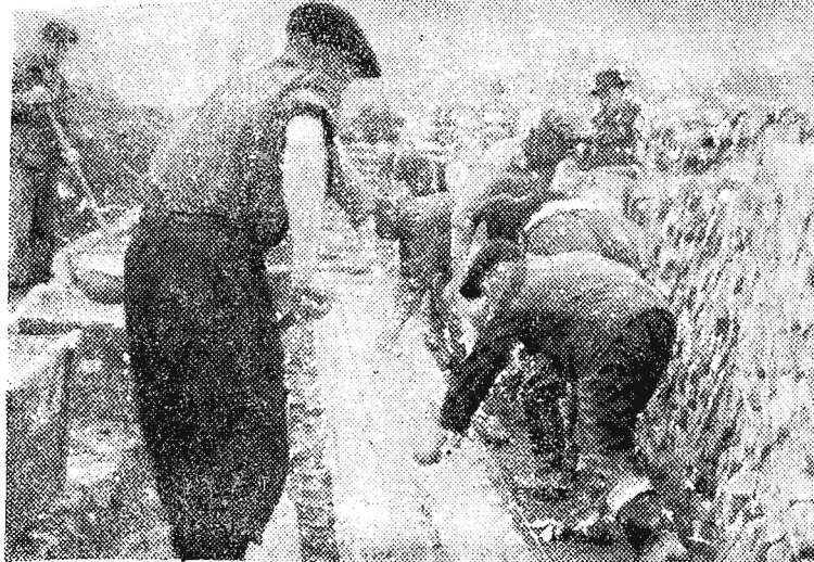
Pierwsze próby zastosowania systemu potokowego na budowlach prowadzonych przez PPB Rzeszów, znalazły uznanie wśród miejscowych murarzy. Na zdjęciu murarze rzeszowscy przy pracy.
