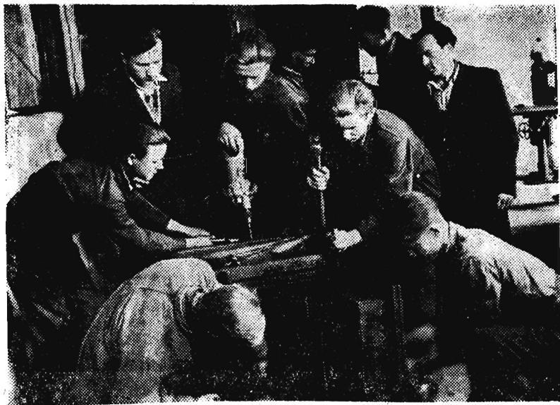
W ramach czynu 1-majowego uczniowie wykonali pomysłową naprawę kasy ogniowatej dla PRZZ w Przemysłu.
