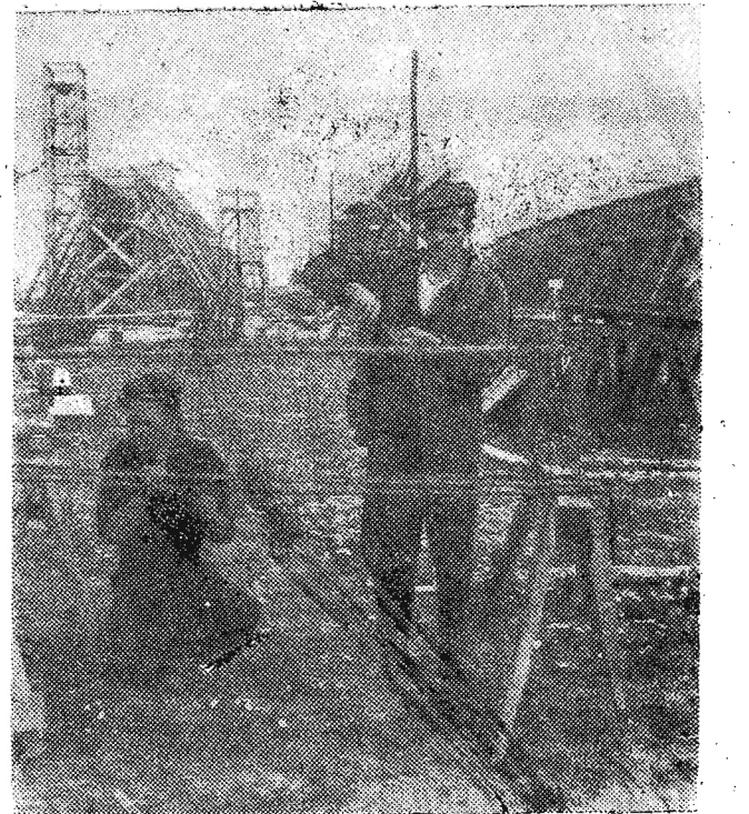
Budowa fabryki samochodów ciężarowych w Lublinie. — CAF. fot. Zygm. Wdowiński
