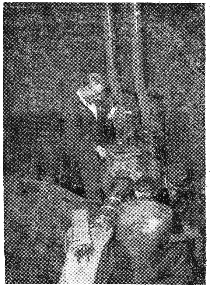
Elektrownia w Dychowie ruszy już w dniu 30 września br. Na zdjęciu: Henryk Kaczmarek i Franciszek Surowiec, z brygady Michała Kościłowa wyrabiającej 167 normy, montują pod kierunkiem radzieckiego specjalisty Mikołaja Myżnikowa turbinę „A”. Caf. — fot. Baranowski
