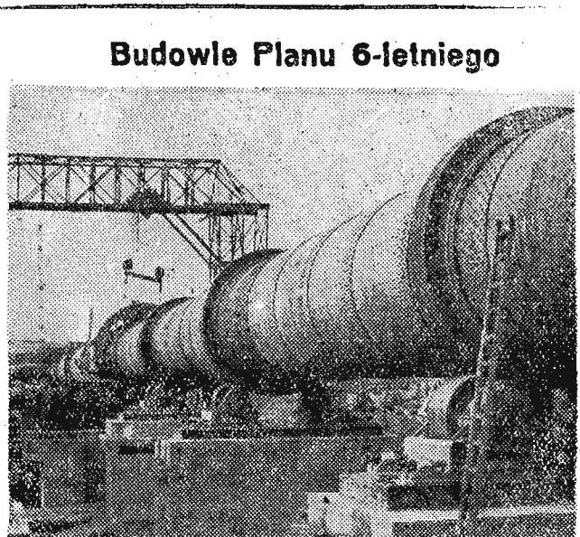
Budowie Planu 6-letniego Załoga budująca wielką, nowoczesną cementownię w Wierzbicy, dla uczczenia 34-rocznicy Rewolucji Październikowej podjęła przyspieszenie o 10 dni, wykonanie planu budowy. Na zdjęciu: Fragment budowanego pleca obrotowego cementowni. CAF — fot. Banduch
