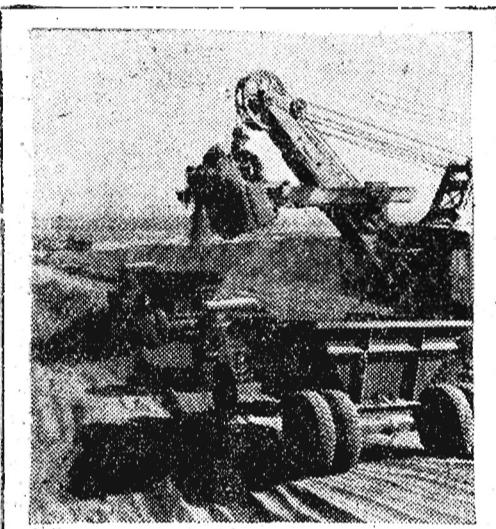
W okolicy Tachla-Tasz trwa budowa kanałów okrężnego i łączącego. Kanał okrężny rozpoczyna się od lewego brzoza Amu-Darri i mijając Tachla-Tasz, wchodzi na trasę Głównego Kanału Turkmeńskiego.
