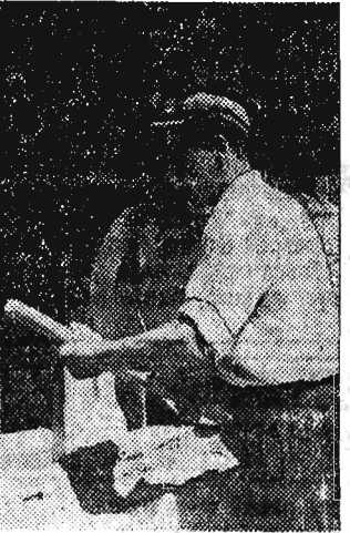
Na zdjęciu: Mieczysław Wisz podczas pracy przy betoniarce.
