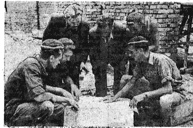
Przed rozpoczęciem pracy młodzi murarze z brygady W Świądra wraz z majstrem zapoznają się z planem budowy
