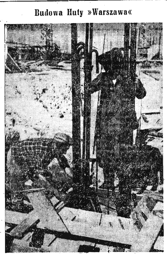
Postępuje szybko naprzód budowa Huty „Warszawa“, jednej z największych inwestycji planu 6-letniego, w dziedzinie hutnictwa. Na zdjęciu: Jan BOCHNEK i Zdzisław SZULC przy zbrojeniu słupów hali warsztatów remontowych. CAF — fot. Pleńkowski.
