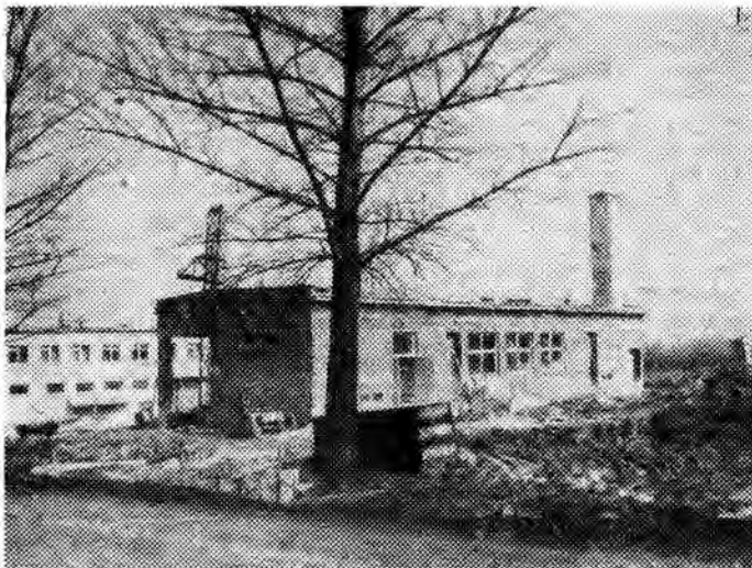
Budowa piekarni we Fredropolu.
