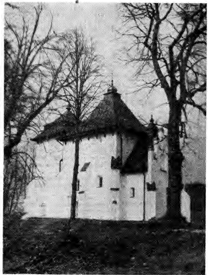
Odrestaurowana zabytkowa cerkiew obronna w Posadzie Rybotyckiej.
