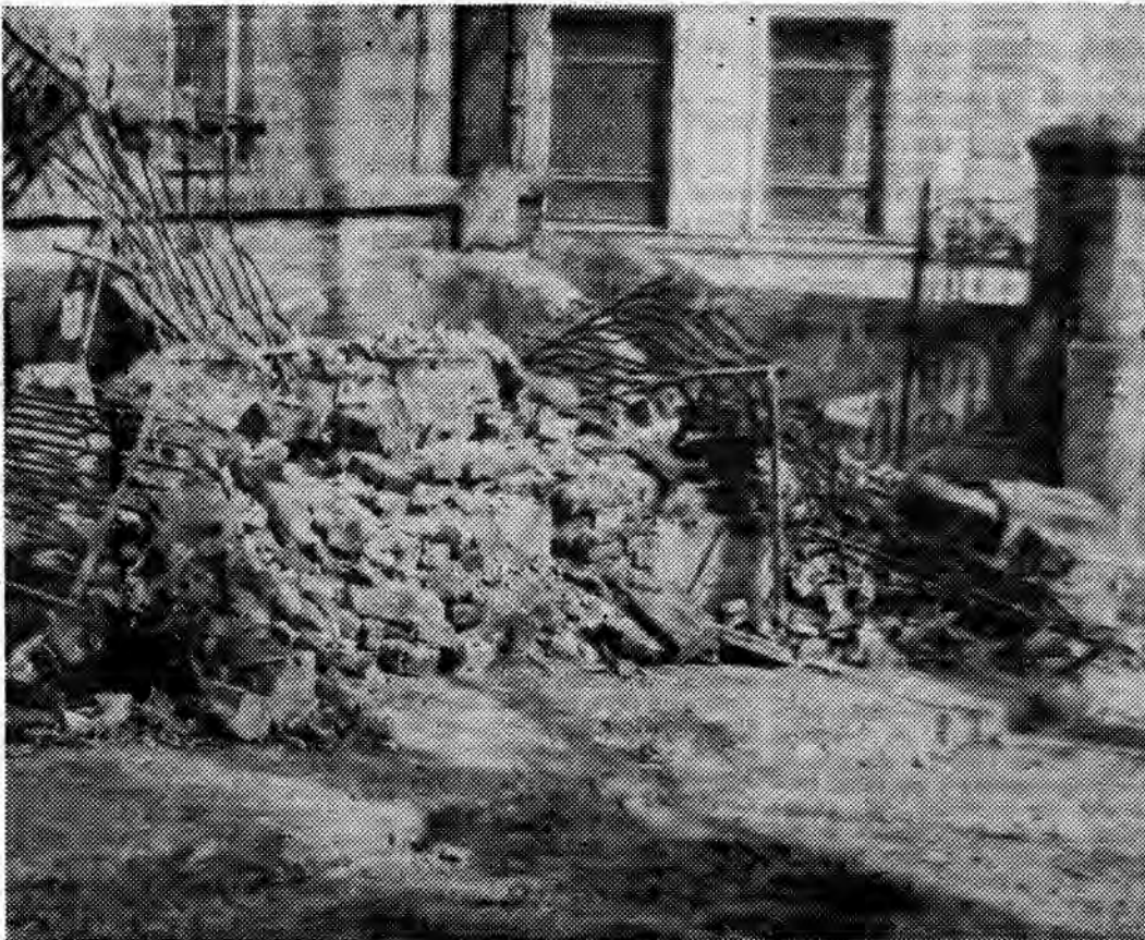
Internat Technikum Gastronomicznego przy ulicy Tatarskiej 6 w Przemyślu oddzielano od ulicy zabytkowe ogrodzenie (mur i ozdobne, żelazne sztachety), liczące sobie ponad sto lat. W 1985 roku mur zaczął pękać i chylić się na bok, o czym poinformowano architekta. Na Wielkanoc bieżącego roku, kiedy w pobliżu odbywało się tradycyjne strzelanie z karbidu, ogrodzenie runęło na chodnik, zagradzając przejście. Reszty dokonał spychacz.
