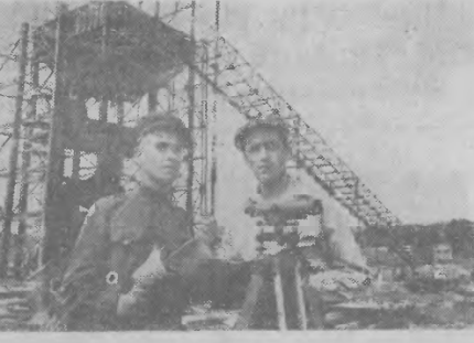
Na obu brzegach Wolgi powstają betoniarne, niezapłane przy budowie elebratowni. Na zdjeciu: Budowa największej zmechanizowanej betoniarni na lewym brzegu Wolgi. Kierownik prac N. Michalowski (po lewej) i inż. godeszi B. Sidorowicz wytyczają w terenie boznice koleje. Fot. — CAF
