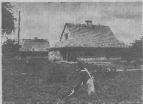
Pracownicy rolni Państwowego Gospodarstwa Rolnego Kołbieryzko w powiecie sieradzkim otrzymali nowowbudowane dwurodzinne domki wraz z pomieszczeniami dla świń i kur i ogródkami przydomowymi. Na zdjęciu: Ogólny widok nowych domków, w których zamieszkali robotnicy rolni. CAF—fot. Szafrharc
