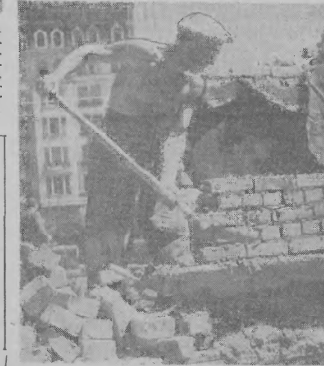
Młodzieżowa trójka murarska, pracująca na MDM w śladzie: murarz Stanisław Kapuśniak i podprzeci Henryk Nisiołowski i Tadeusz Głowicz, wykonała rodjęte zobowiązanie złotowe. W ciągu 8 godzin pracy postawił mur o długości 38,5 m. Trójka Kapuśniaka pobila jednocześnie rekord Polski w murarce, ustanowiony przez trójkę olsztyńska, kładąc 28.022 cegły. Na zdjęciu: Stanisław Kapuśniak przy pracy. CAF — fot. Szyperko
