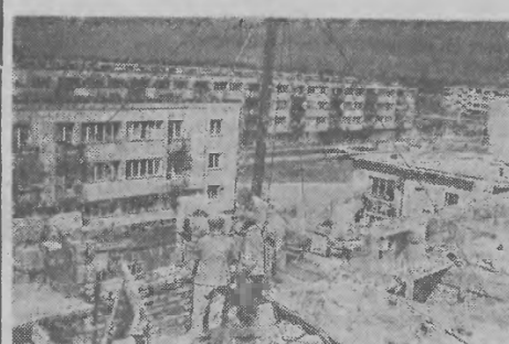
Budowa osiedla mieszkaniowego KOŁO w Warszawie, postępuje szybko naprzód.
