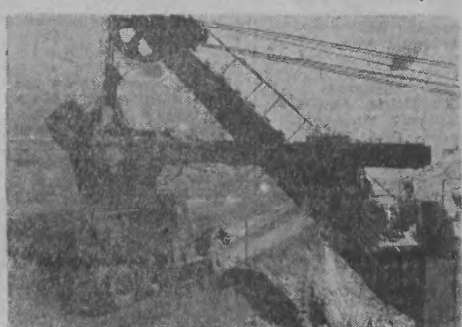
Między rzekami Wołgą a Uralem buduje się gęsta sieć kanałów. Na budowie kanału Wołga — Ural długości około 650 km dzień i noc pracują liczne kopaczki, buldożery i inne maszyny budowlane.
