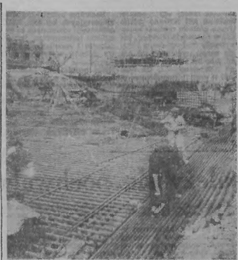
W Nowej Hucie trwają intensywne prace przy budowie Zakładu Koksociemnego...
