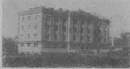
Gmach Wojewódzkiej Komisji Planowania Gospodarczego. Obok niego wyrósł już nowy, równie wspaniały gmach Komitetu Wojewódzkiego PZPR. W pobliżu dworca kolejowego stoi nowy hotel. Budynków takich będzie coraz więcej zgodnie z założeniami naszego wielkiego planu.
