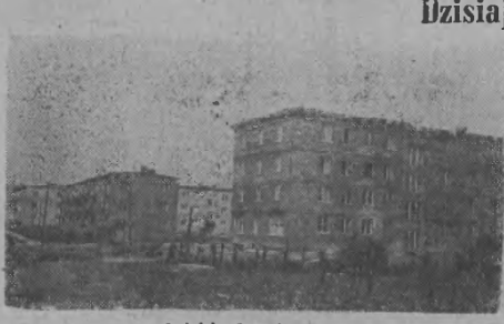
Na Koszarce — przedmieściu Katowic — powstaje piękne nowoczesne osiedle mieszkaniowe im. Juliana Marchlewskiego. Na zdjęciu: Fragment osiedla. CAF — fot. Noga
