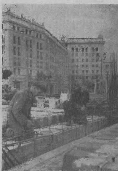
Brygada zbrojarzy Jana Hordeja dla szeregów XIX Zjazdu WKP(b) zaciągnęła w dniach od 8. X. do 9. X. br. warty produkcyjne wykonujące w tym czasie 225 proc. zamłast 215 proc. Na zdjęciu: Jan Hordej i Michał Ptaszyński przy zbrojeniu słupów na bloku 21. CAF — fot. Zyg. Wdowiński
