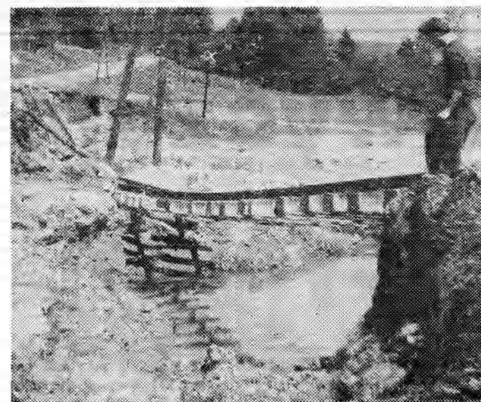
Tędy „ciuchcia” z Dynowa do Przeworska nieprędko przejeździe: woda „zabrała” nasyp spod torów.
