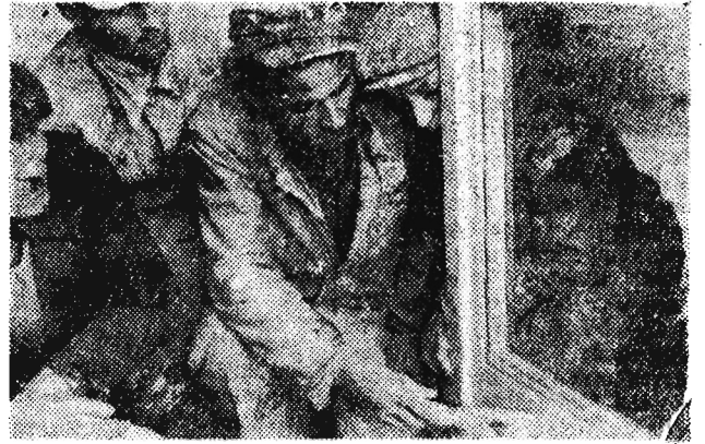
Pracownicy przodującej brygady malarskiej Franciszka Hockuby swoje zobowiązanie 1-majowe — dotyczący wykonania wszystkich prac malarskich i tynkarskich na budowie 1/100 na 5 dni przed terminem — zrealizowali już w dniu 14 kwietnia. Brygada wykonuje swoje dzienne zadania w 234 proc.
