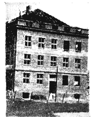
Budynek Technikum Budowlanego w Rzeszowie, który jeszcze 2 tygodnie temu miał wygląd jak na zdjęciu powyżej, obecnie jest już całkowicie wykończony, aby przywitać po raz pierwszy swoich uczniów.
