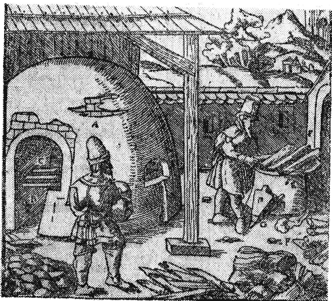
Piec płomienny albo trybowy do odciągania srebra od ołowiu.
