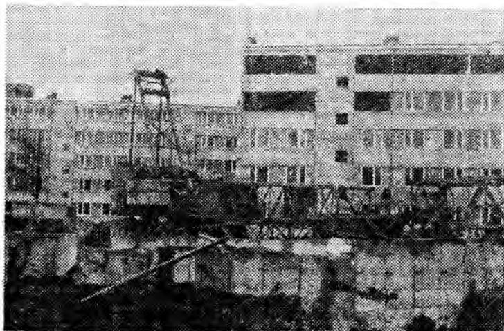
Nowy Jarosław w budowie.
