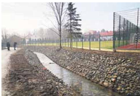
Do umocnienia brzegu wykorzystano specjalne siatki wypełnione kamieniami
