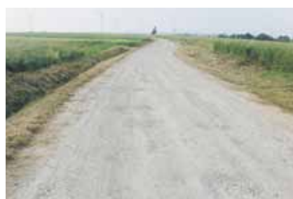
Droga Przecznice w Soninie przed przebudową
