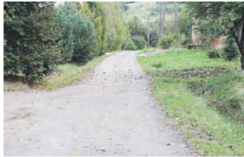
Tak wyglądała droga przed przebudową
