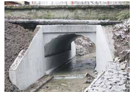
Został wzmocniony poprzez zamontowanie betonowej konstrukcji FOT. BERNADETA BRÓZ
