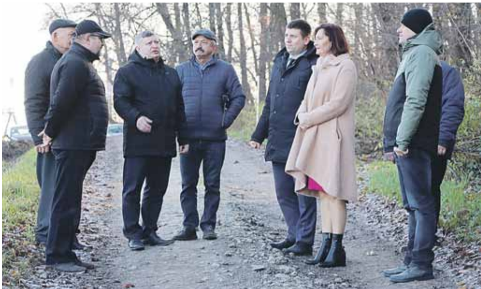
Wojewoda odwiedziła także teren budowy drogi Albigowa Granice, która połączy centrum wsi z Markową. Realizacja inwestycji zakończy się 2023 roku. FOT. BERNADETA BRÓZ
