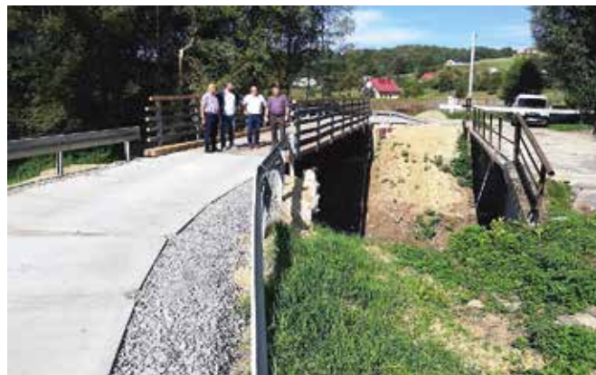
Tymczasowy most obok zniszczonego powstał dzięki wsparciu finansowemu Gminy Kleszczów
