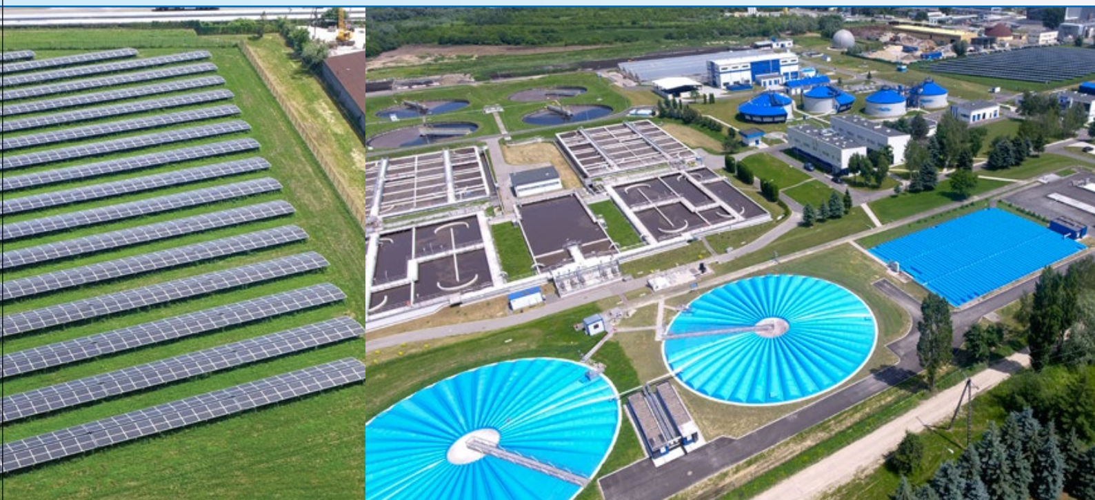
Oczyszczalnia Ścieków w Rzeszowie
