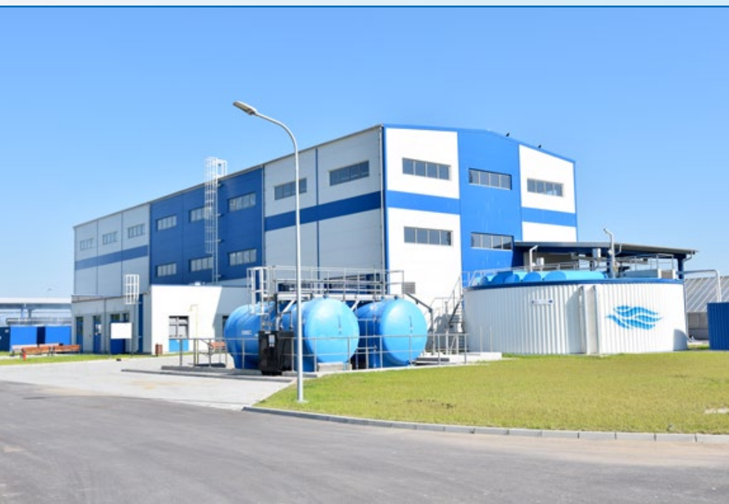
Budynek suszarni mechanicznej osadów ściekowych
