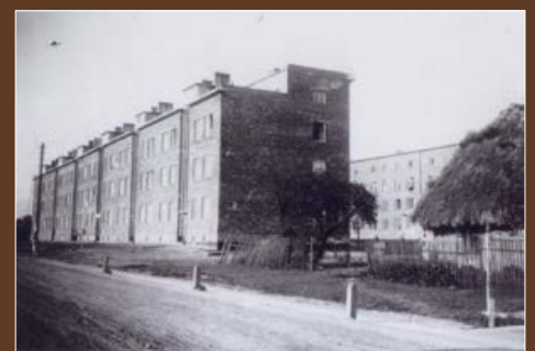
Dwa bloki robotnicze (172 mieszkania) wybudowane przed wojną przy ulicy Hetmańskiej w Rzeszowie dla pracowników Fabryki Obrabiarek i Sprzętu Artyleryjskiego. Projektował je arch. Tadeusz Mulicki. Bloki powstały w latach 1937–1938. Po stronie prawej dom pod strzechą rodziny Gieroniów
