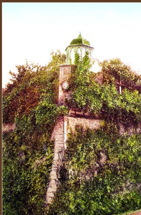
Zamek Lubomirskich, narożnik wschodni
