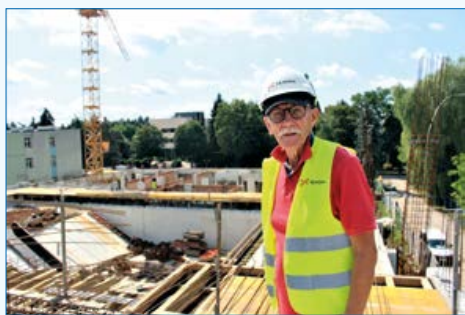
Trainer Ryszard Wojtaszewski na budowie basenu
