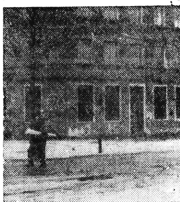
Wąskie, wysoko umieszczone wcięcia nie wystawowe okna sklepów.
