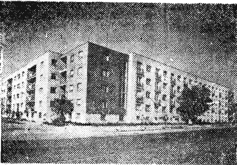
W nowych Węgrzech buduje się słończne i nowoczesne mieszkania. W roku 1954 wybudowano o 65 proc. więcej niż w roku poprzednim.
