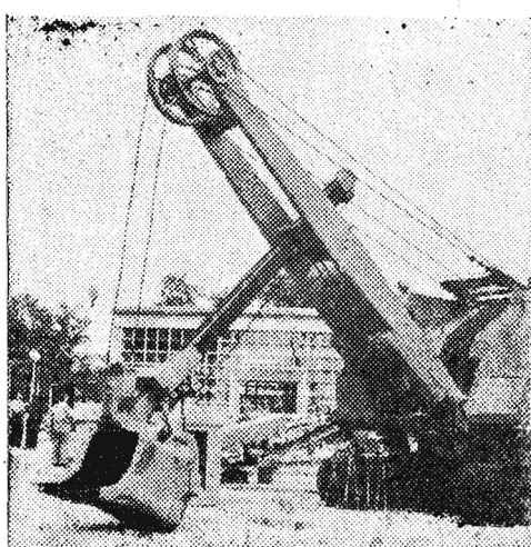
Na zdjęciu: Koparka polskiej produkcji na otwartych terenach targowych. W głębi fragment Pawilonu Budownictwa. CAF — fot. Baranowski
