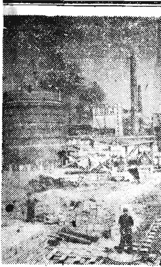
W rejonie koksochemii Kombinatu Hutniczego im. W. Lenina prowadzone są intensywne prace przy budowie 5 i 6 baterii koksoowniczej. Na zdjęciu: Fragment rejonu budowy. Fot. CAF.
