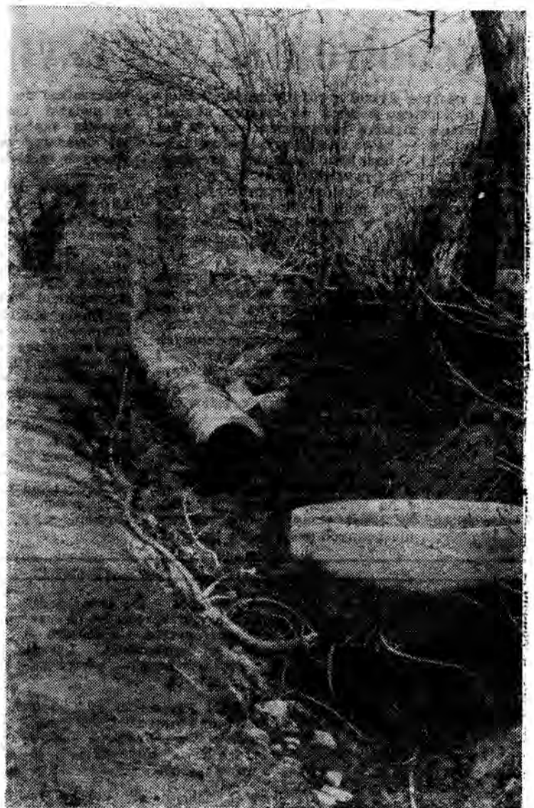
W Białobokach trzeba zakończyć budowę kolektora.
