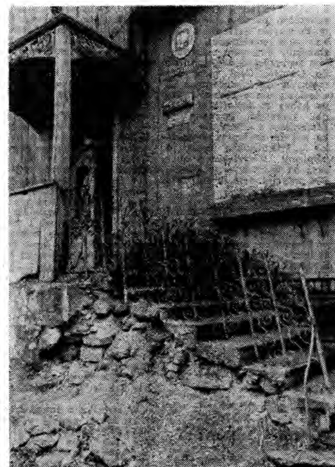
Schody budynku poczty w Birczy w rozsypanie.
