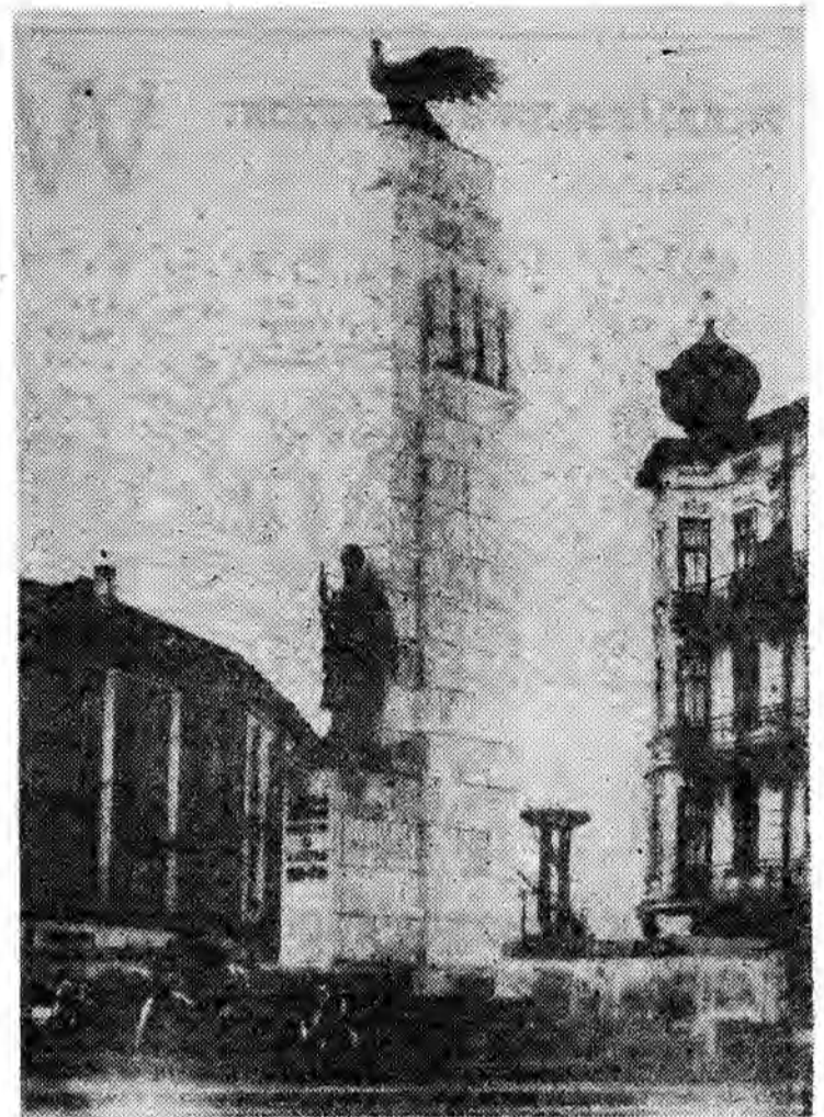
Tak wyglądał pomnik Orłąt Przemyskich wybudowany w 1938 roku na placu Konstytucji 3 Maja.
