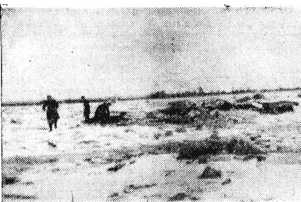
Zwały kry kruszono ładunkami wybuchowymi zakładanymi pod lód.
