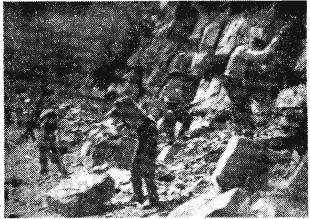
Budowa podłoża kolejki leśnej Rzepedź-Mików.
