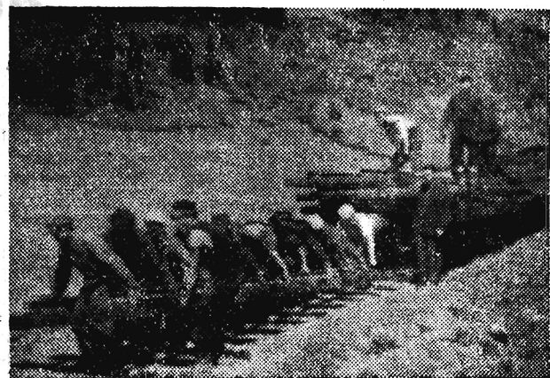
Układanie szyn dla kolejki wąskotorowej.
