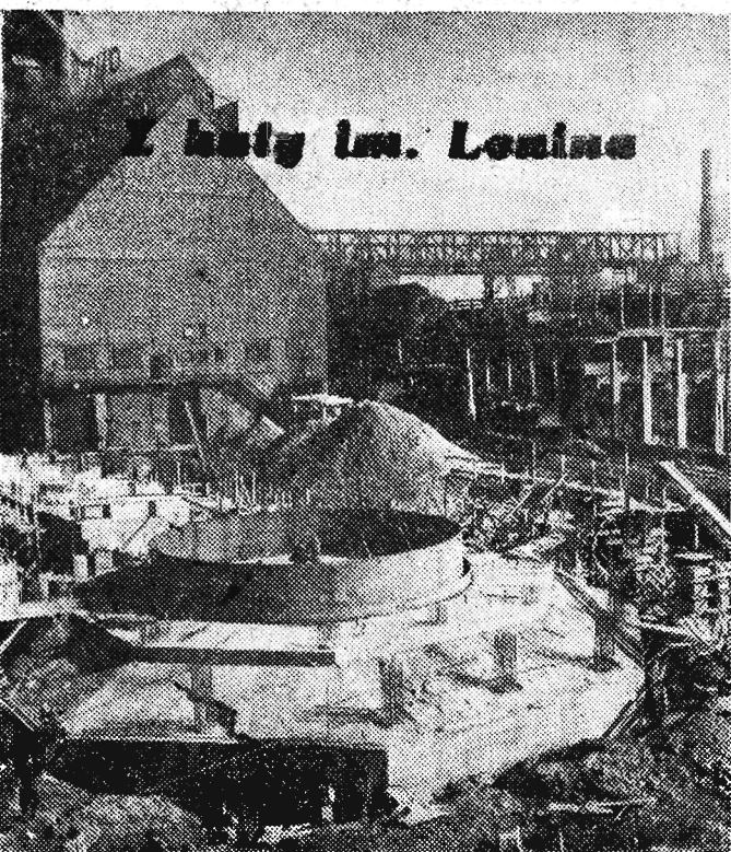
W hucie im. Lenina przystąpiono do montażu korpusu III wielkiego pieca. Osobno montuje się z płyt stalowych tzw. „cargi”, które potem przy pomocy dźwigów układa się do montażu jedna na drugiej. Przed montażem wszystkie sprawy „cargów” są prześwietlane promieniami Rentgena. Na zdjęciu: Fragment budowy III wielkiego pieca. Fot — CAF
