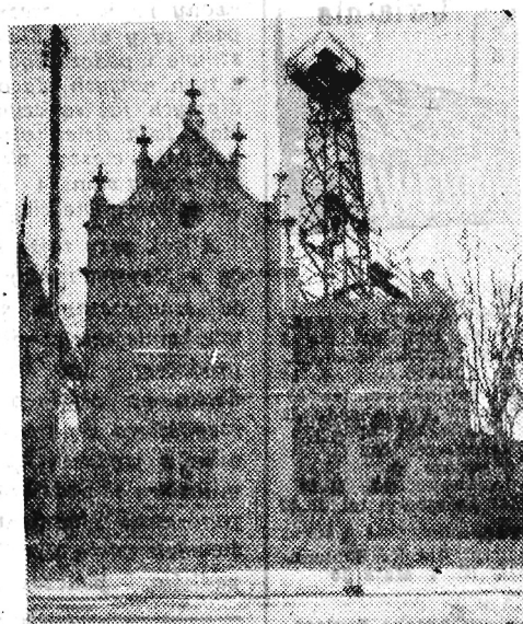
Na zdjęciu: Stacja telewizyjna z zainstalowanym masztem.
