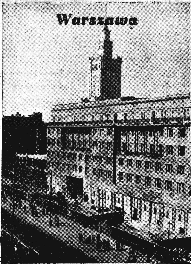
Na zdjęciu: W Alejach Jerozolimskich, postępuje budowa nowych bloków mieszkalnych.
