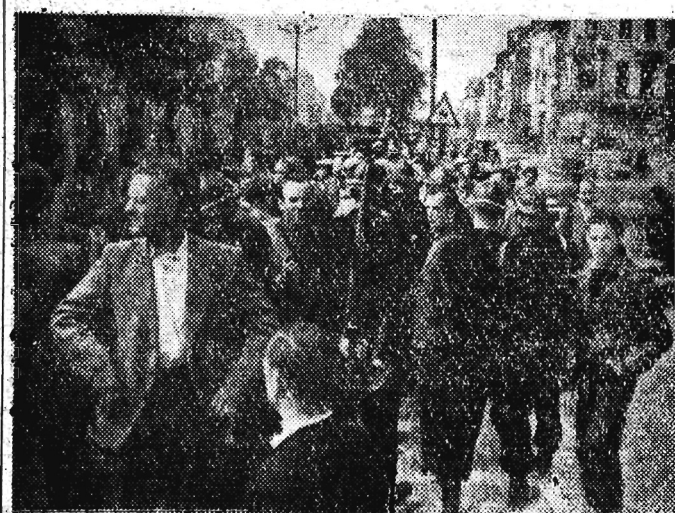
Zandarmi rozpędzają robotników budowlanych, którzy zajęli tunel Porte Louise. Fot — CAF
