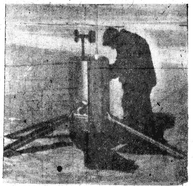
To zabawne urządzenie, które zrzucone ze spadochronu potrafi samo stanąć na nogach” (stad nazwa konik polny) służy do przekazywania danych meteorologicznych. Posługują się nim amerykańscy badacze Antarktydy. CAF.
