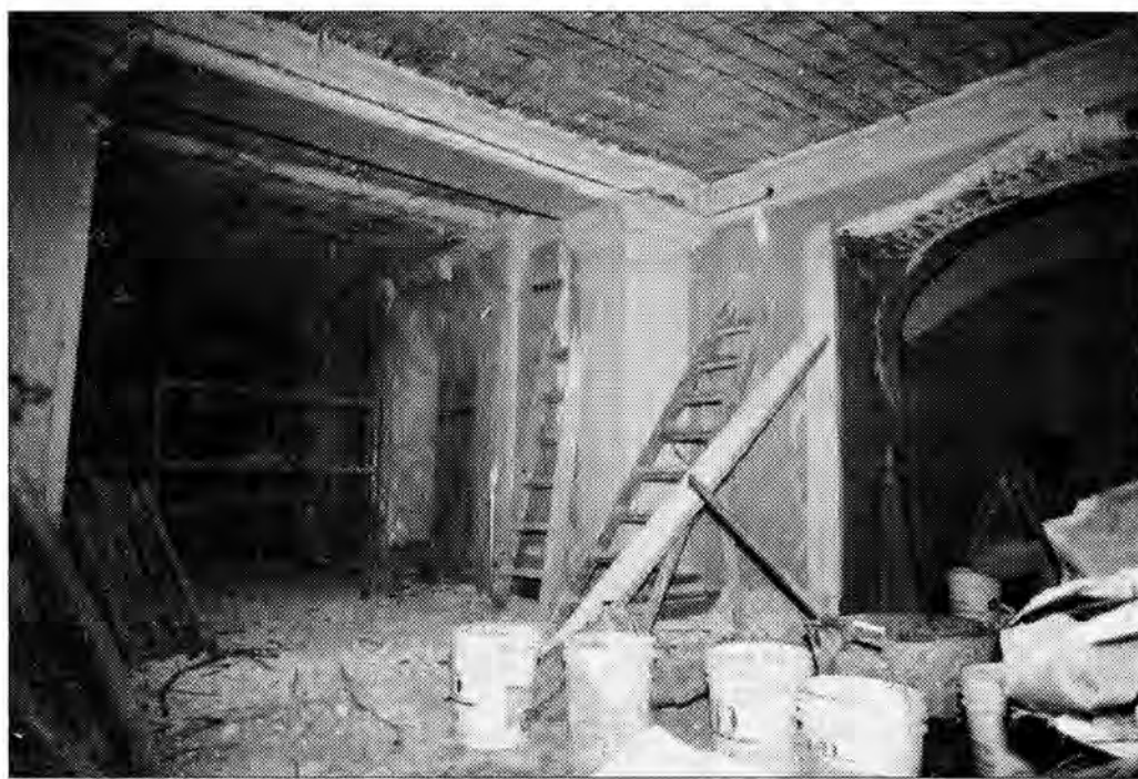
Wyremontowana fasada, nowe drzwi... a w środku?
